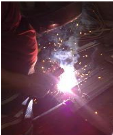
Слика 5 Пробно експерименталне заваривање Е-поступком са рутилном и базичном електродом
